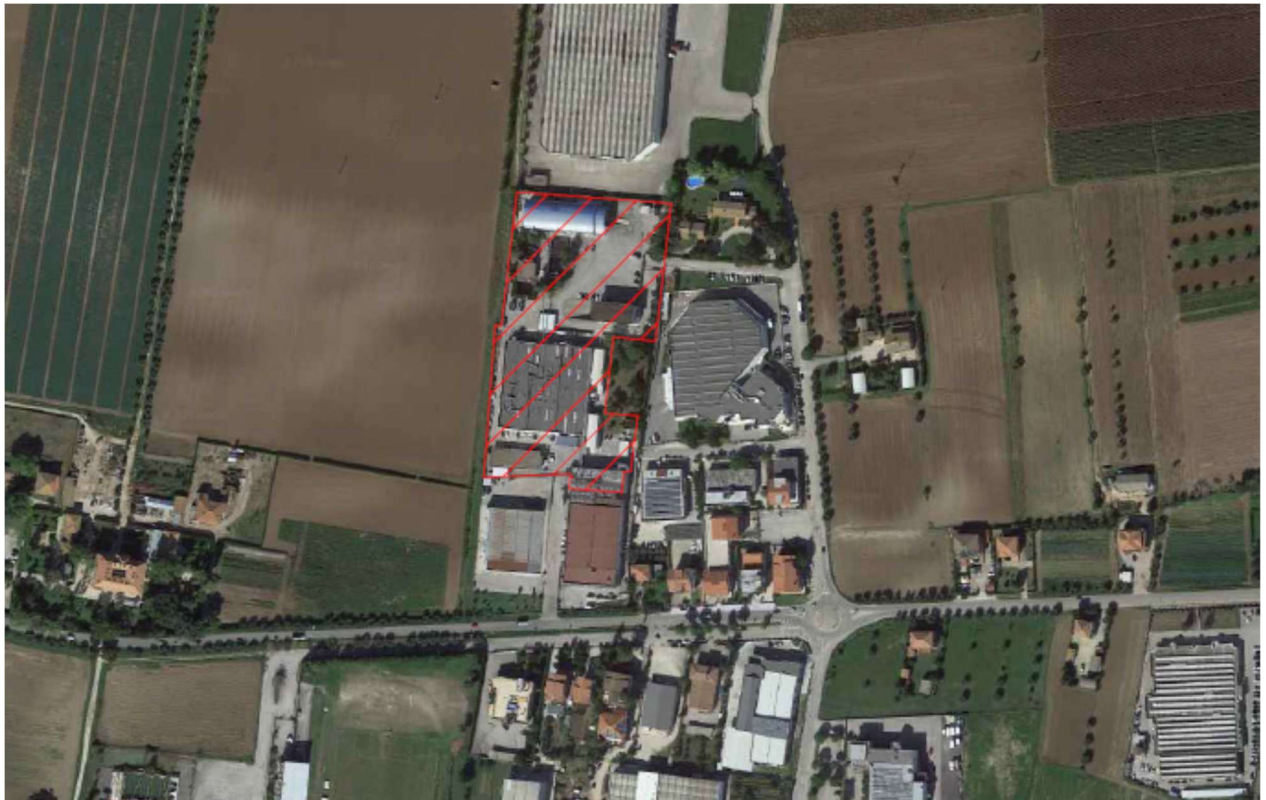
Immagine aerea della proprietà Freudenberg in Sant'Omero (Te) Via Metella Nuova SS259 e oggetto di intervento
